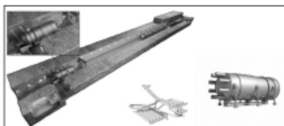
図4 SFR2の1BRT岩盤Vault鳥瞰図 (原子炉压力容器専用の収納施設)
