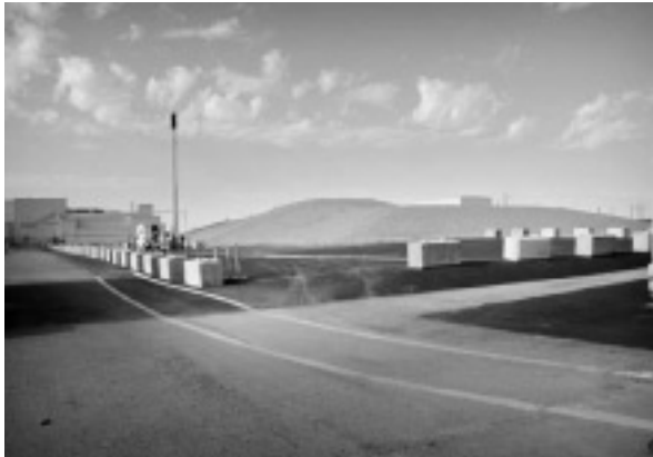
図1 建屋601/640 の埋設段階
