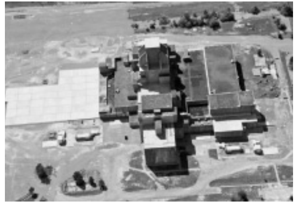
図2 ISD後のP原子炉施設
